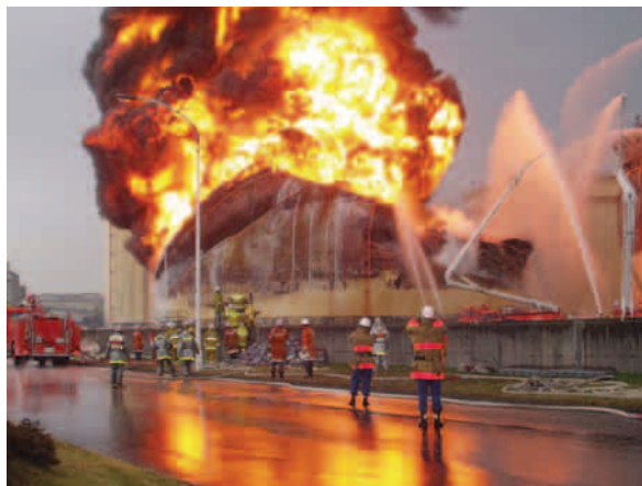
石油タンク全面火災における消火活動
